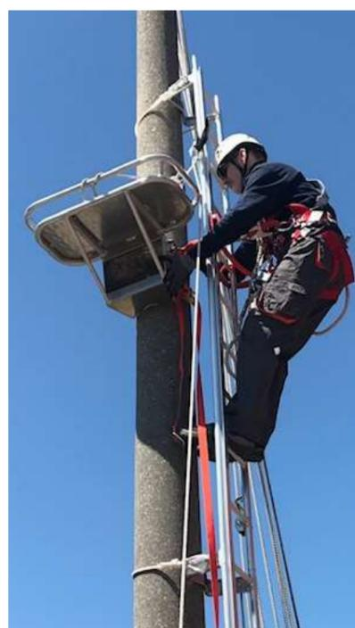
Страховочная привязь с интегрированным монтажным поясом и четырьмя точками крепления: наспинной, нагрудной и двумя боковыми. - Профессиональная и ультраоблегченная модель - Набедренные лямки оборудованы сидением - Привязь совместима со страховочными системами, соответствующими стандарту EN363 - Рассчитан на рабочих с максимальным весом 130 кг.
