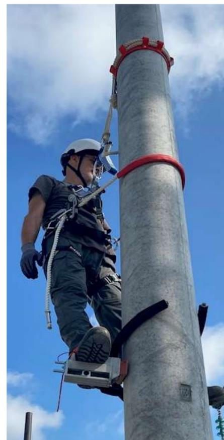
STAFFE MONTAPALI PER PALI TUBOLARI IN CEMENTO E FERRO
