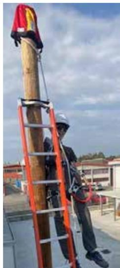
**DISPOSITIVO D'ANCORAGGIO TRASPORTABILE PER PALI IN CEMENTO FERRO E LEGNO**
