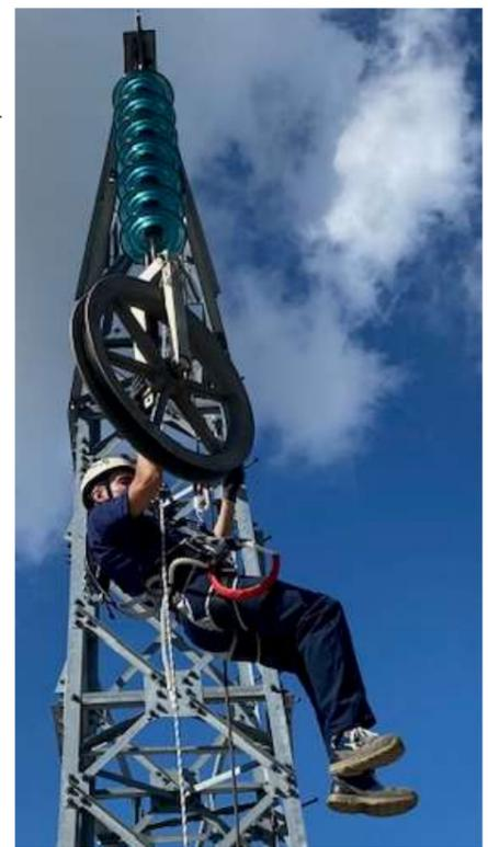
IMBRACATURA PER IL CORPO CON CINTURA DI POSIZIONAMENTO – MOD. PROFESSIONALE
