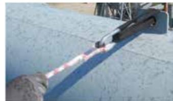
Creazione del 1° punto d'ancoraggio con l'ausilio di una fettuccia
