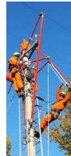
Tutte le scale per salita pali e tralicci da noi prodotte sono state certificate EN795 cl. b In particolare modo è stato certificato l'incrocio fra il montante scala e il gradino ove è possibile la connessione di un connettore o fettuccia tessile
