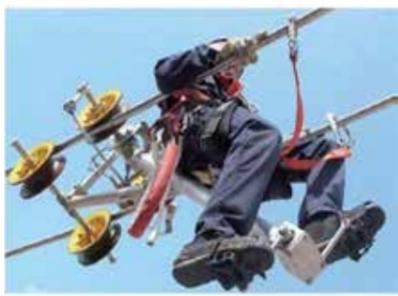
CARROZZINO PER ISPEZIONE CONDUTTORE BINATO - TRINATO
