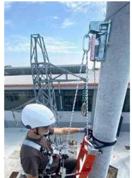
Осознанный подход к выбору средств защиты и оборудования имеет решающее значение для безопасности работника; в случае, когда невозможно производить работу из корзины автогидроподъемника, что является самым безопасным методом, целесообразно остановить свой выбор на следующих системах:
