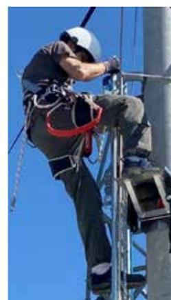
Per la movimentazione sulla scala, l'operatore deve impiegare un'imbracatura per il corpo EN361-358 con attacco sternale – In caso di spostamento su una pedana autopartante (ved.pag. N6) lo stesso deve obbligatoriamente utilizzare un dispositivo d'ancoraggio trasportabile EN795 cl.b (ved.pag.P10÷P14 – P19)
